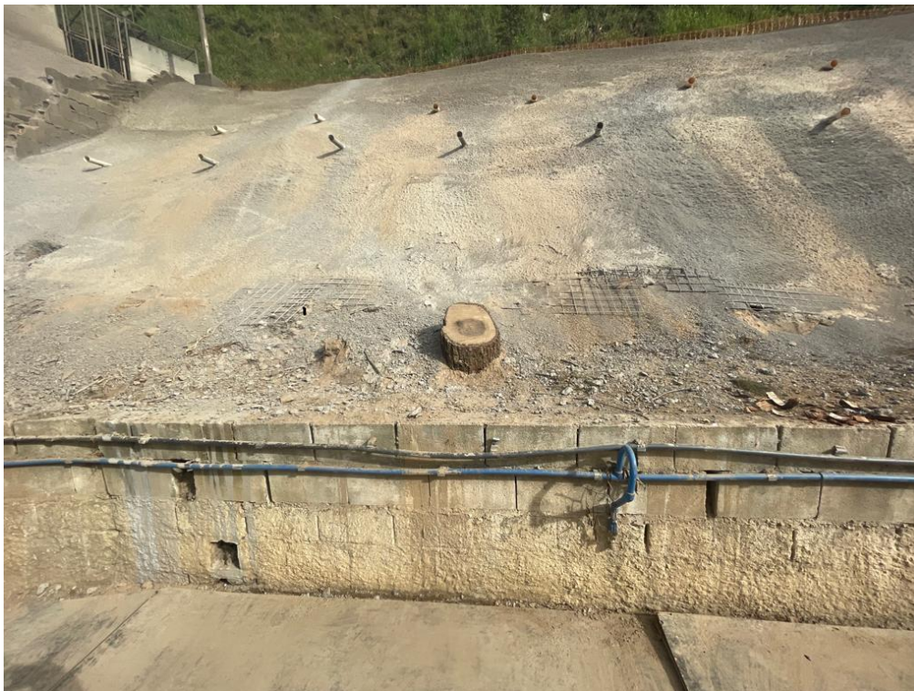
Detalhe das armaduras ainda não recobertas
