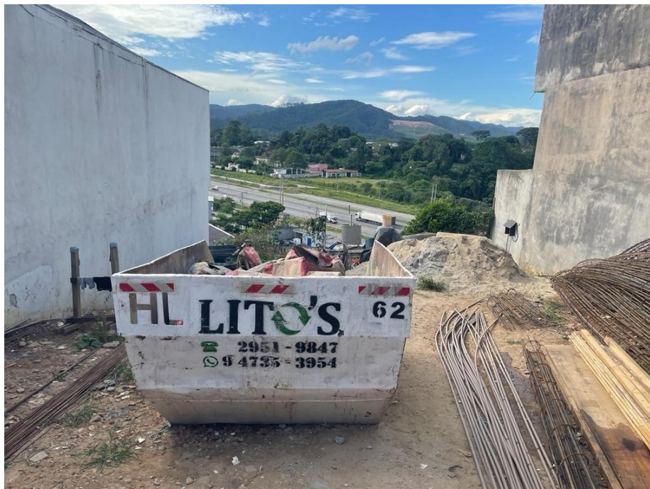
Foto 2 – Endereço a Rua Brinco da Rainha nº 80, vista da Rodovia Anhanguera
