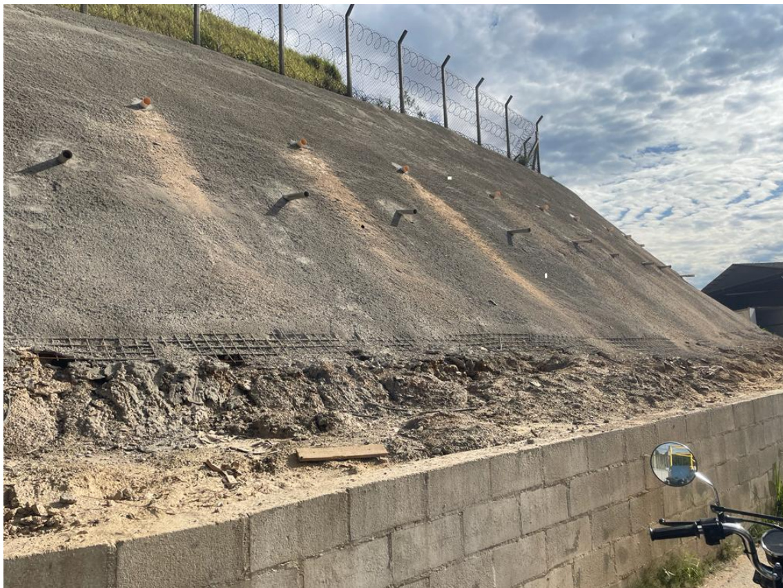
Foto 15 – Revestimento do Talude e contenção inferior
