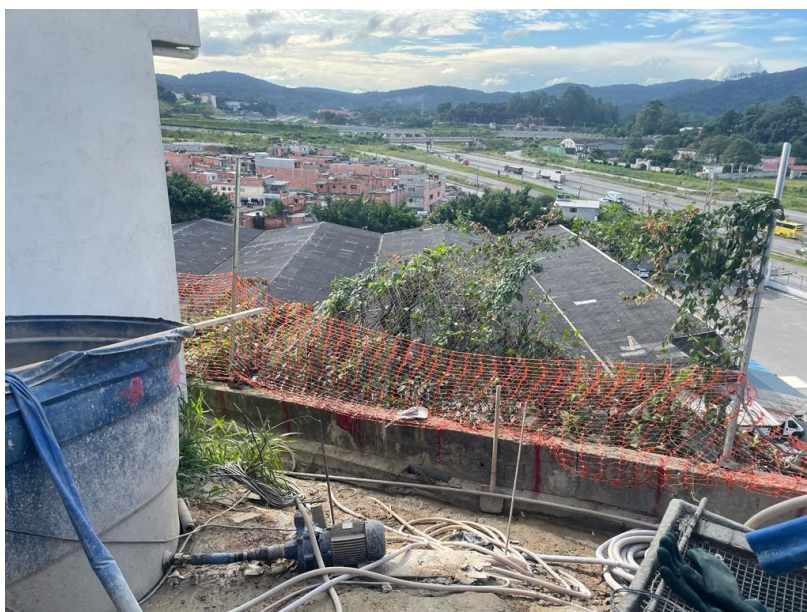
Foto 4 – Detalhe da viga
