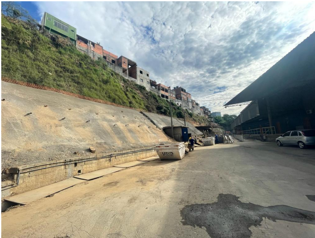
Foto 13 – Vista da parte já completada
