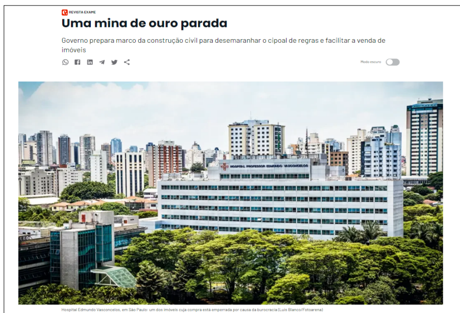
Figura 9 - Prédio 2 – Fachada (ver figura 16, fl 196, Peça 28)
