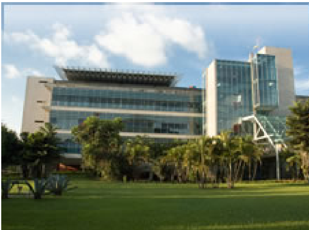
Figura 7 - Prédio 1 – Fachada com heliponto perceptível e esquadrias e cobertura metálica de alto padrão (ver figura 12, fl. 195, Peça 28)
