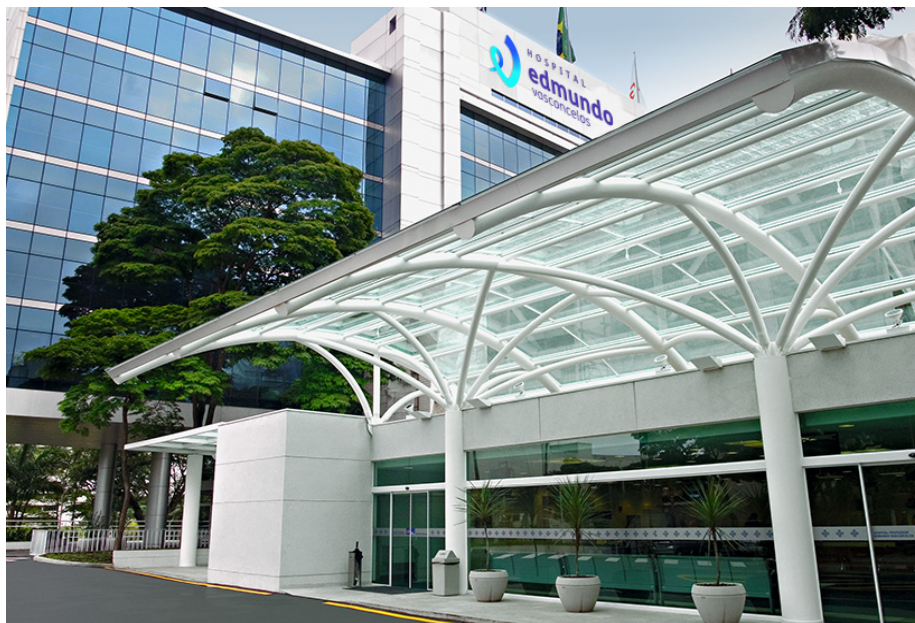
Figura 8 - Prédio 02 – apresentando esquadrias de alto padrão e estrutura de cobertura metálica treliçada na recepção
