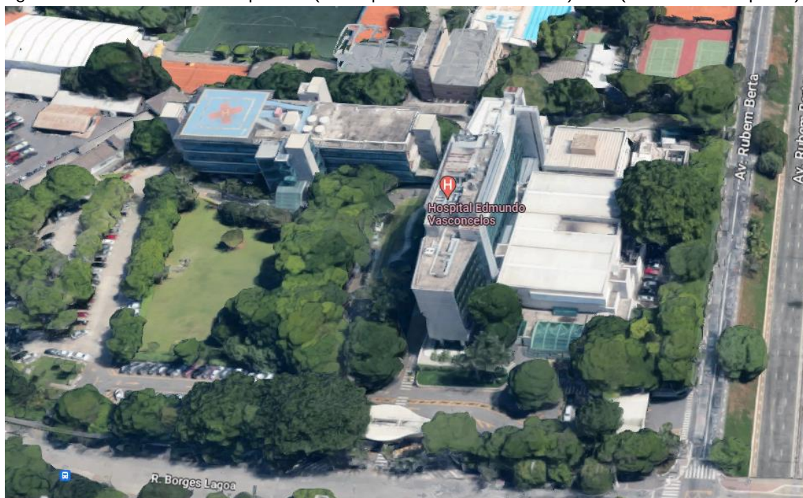
Figura 6 - Visão Geral com os prédios (frente para a Av. Rubem Berta) e 01 (lateral com heliponto).
