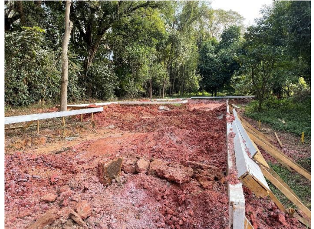
Foto 06: Locação de obra do edifício de serviços.
