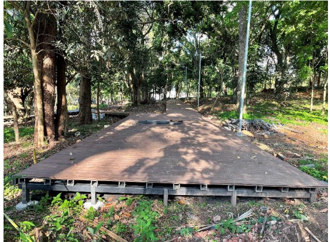
Foto 12: Piso deck em madeira plástica
