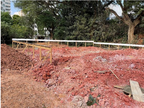
Foto 05: Locação de obra do edifício de serviços.
