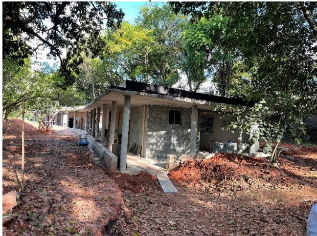
Foto 13: Edifício de serviços
