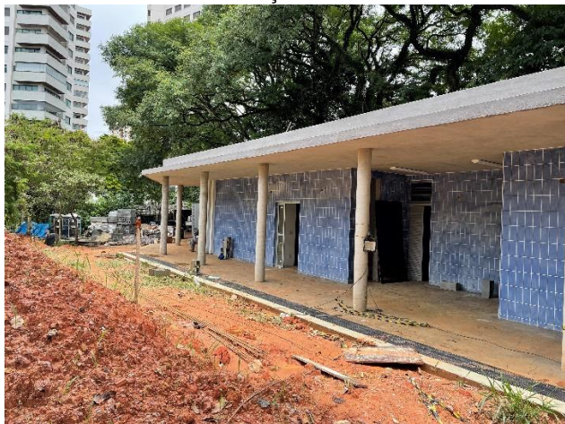
Foto 25: Edifício de serviços
