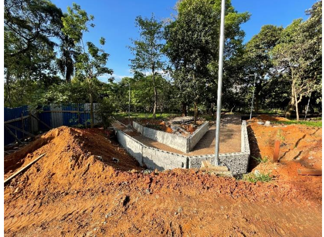
Foto 10: Mureta de arrimo em bloco de concreto
