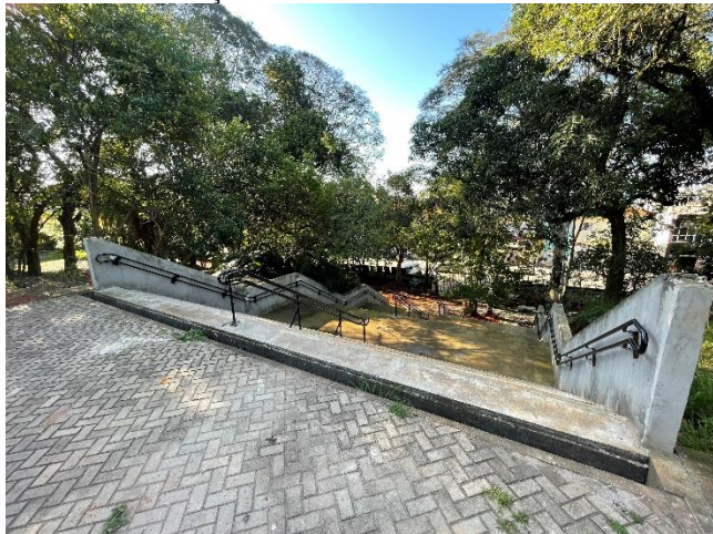
Foto 17: Instalação de corrimão em escadaria
