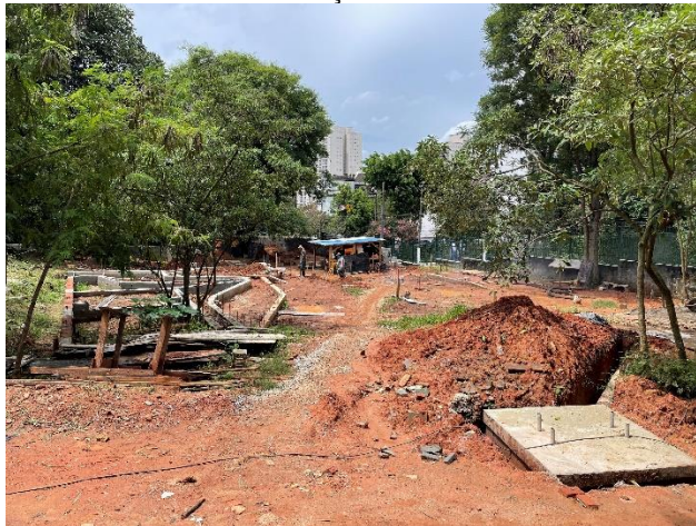
Foto 26: Edifício de serviços
