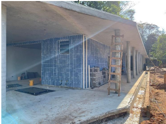
Foto 15: Edifício de serviços
