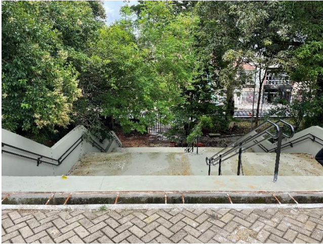
Foto 29: Escadaria com corrimão instalado
