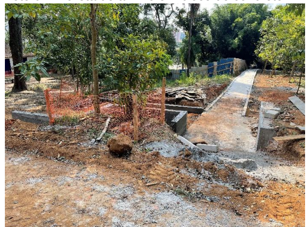
Foto 04: Mureta de arrimo em bloco de concreto
