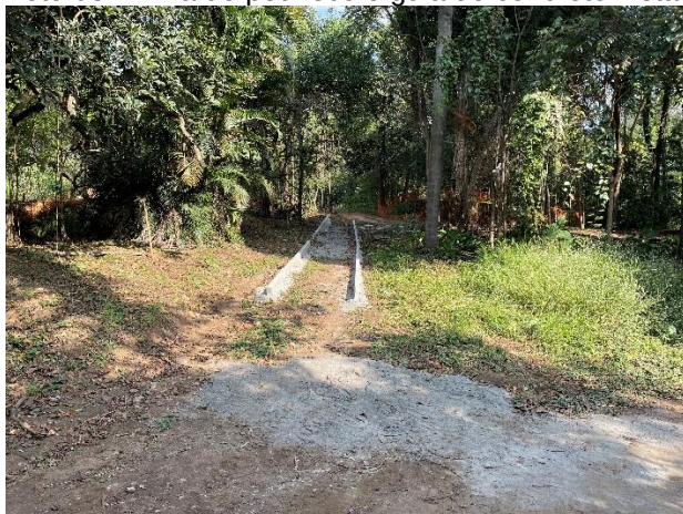
Foto 03: Trilha de pedrisco e guia de concreto instalada.
