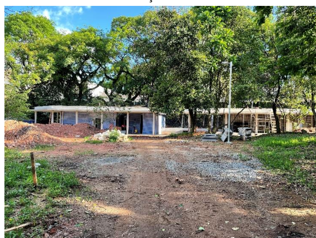
Foto 16: Edifício de serviços
