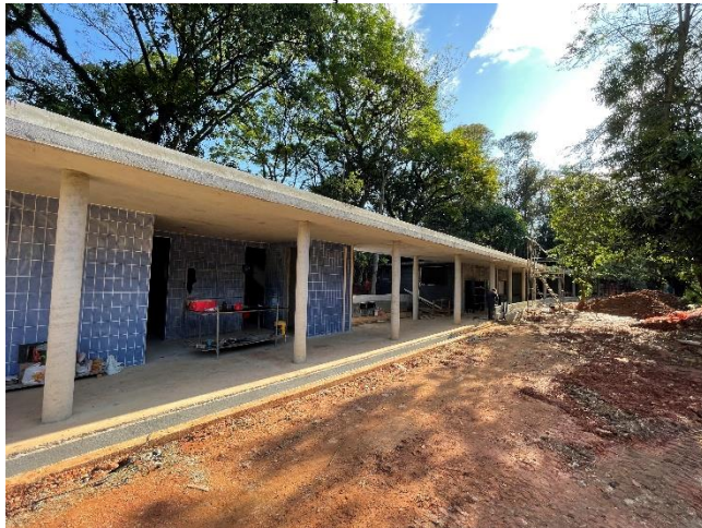
Foto 14: Edifício de serviços
