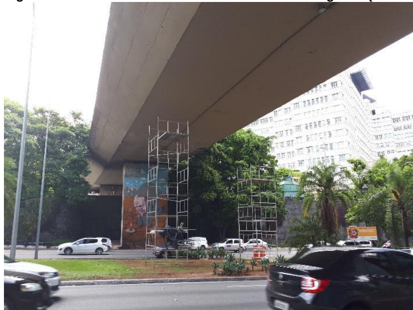
Figura 3 – Andaimos no Viaduto Beneficência Portuguesa (fev/2019)
