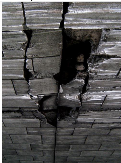
Figura 6 – Situação do viaduto em 2007
