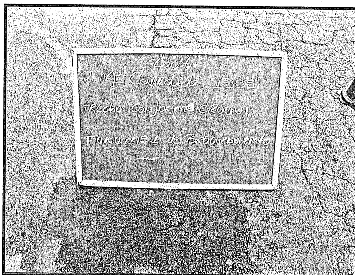
Fechamento do Furo N.º 1 do Broqueamento com Massa Asfáltica.
